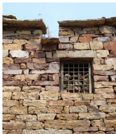
图11 临街墙体窗户
