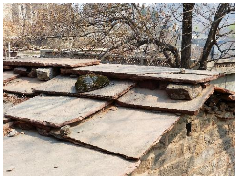
图14 屋顶覆以嶂石岩板
